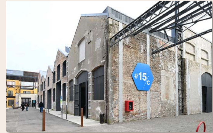
Capannone 15C (AULE)
